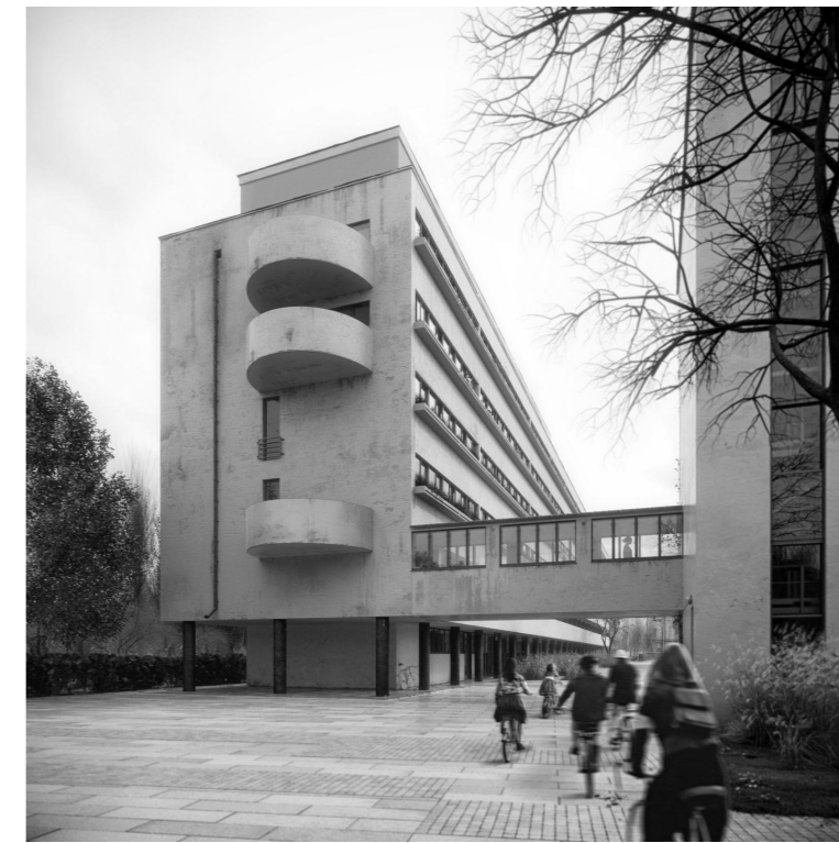
Pilt 21. Narkomfini ühiselamu Moskvast, Nõukogude Venemaa üks esimesi ühiselamuid, mis valmis 1930.aastal. Allikas: Google pildiotsing
